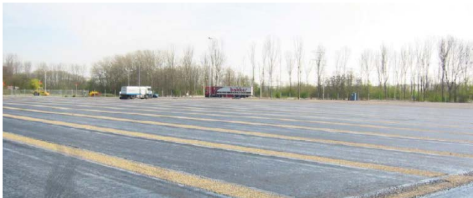
Foto: Aanleg vloeistofdichte asphaltconstructie (bron: VBW Handleiding vloeistofdichte bitumineuze constructies).
