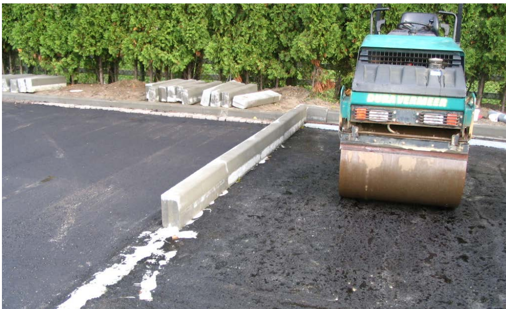
Foto: Verdichten van het asfalt
